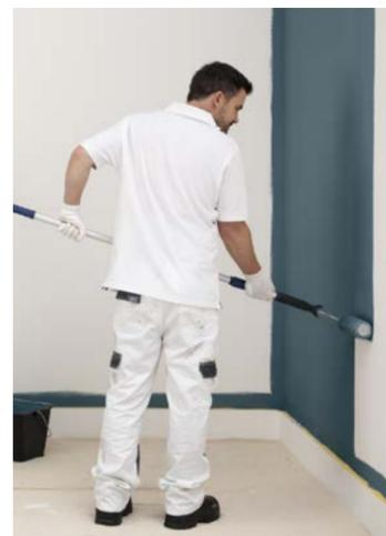
При покраске больших площадей смешайте несколько банок в одной емкости. Красить необходимо целыми элементами по технологии «от угла до угла». Это позволит получить равномерно окрашенную поверхность.
